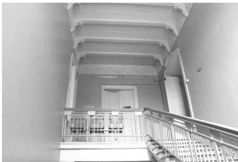
Лестница. Помещение № 20 (в соответствии с техническим паспортом ОГУП «ОЦТИ – Областное БТИ» г. Иркутск по состоянию на 20 декабря 2014 года)
