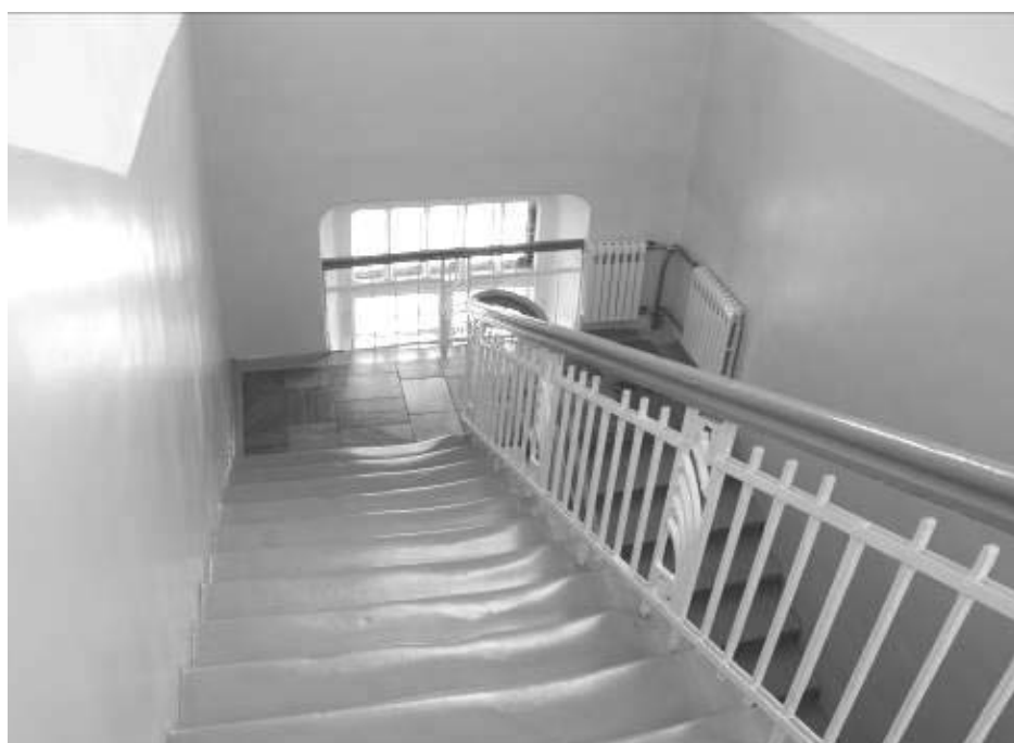
Лестница помещение № 1 (в соответствии с техническим паспортом ОГУП «ОЦТИ – Областное БТИ» г. Иркутск по состоянию на 20 декабря 2014 года)
