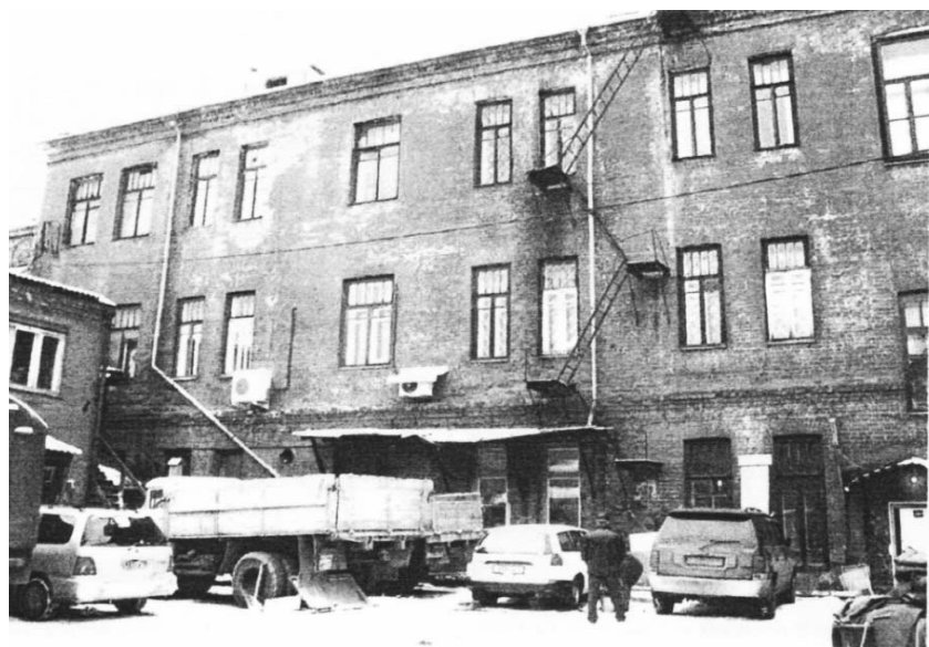
8. Дворовой фасад по ул. Маркса Маркса, 28. Современные фотографии (ноябрь 2008 г.)
