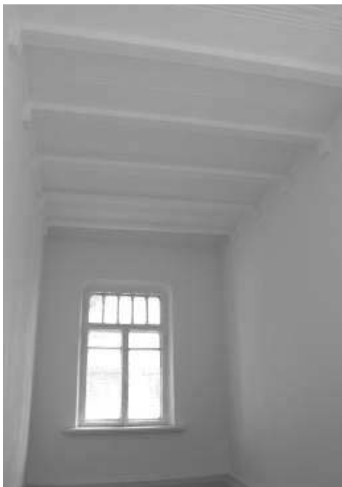
Фрагмент потолка помещения № 1. Лестница (в соответствии с техническим паспортом ОГУП «ОЦТИ – Областное БТИ» г. Иркутск по состоянию на 20 декабря 2014 года)
