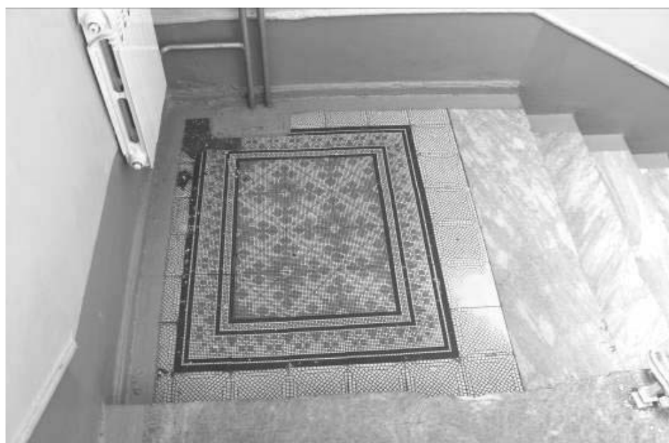
Мозаика. Помещение № 18 (в соответствии с техническим паспортом ОГУП «ОЦТИ – Областное БТИ» г. Иркутск по состоянию на 20 декабря 2014 года)
