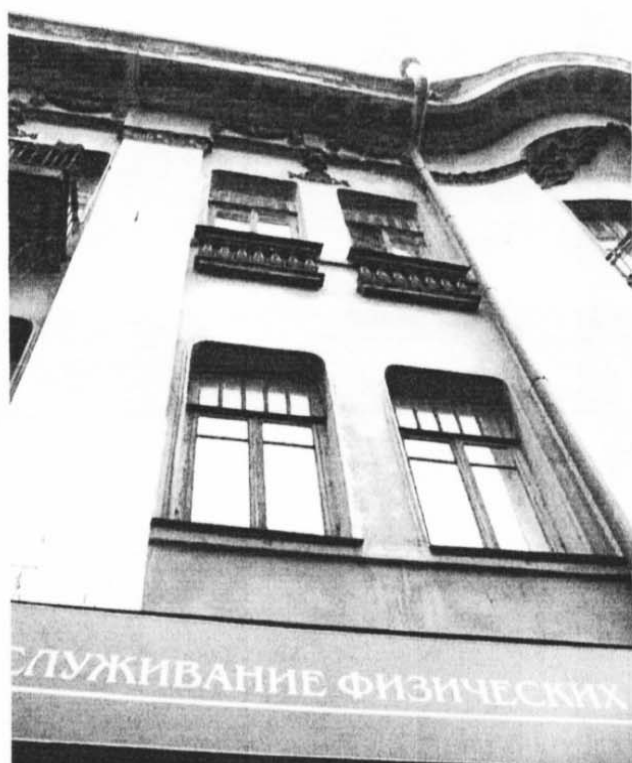
15. Окна второго и третьего этажей на фасаде по ул. Маркса
