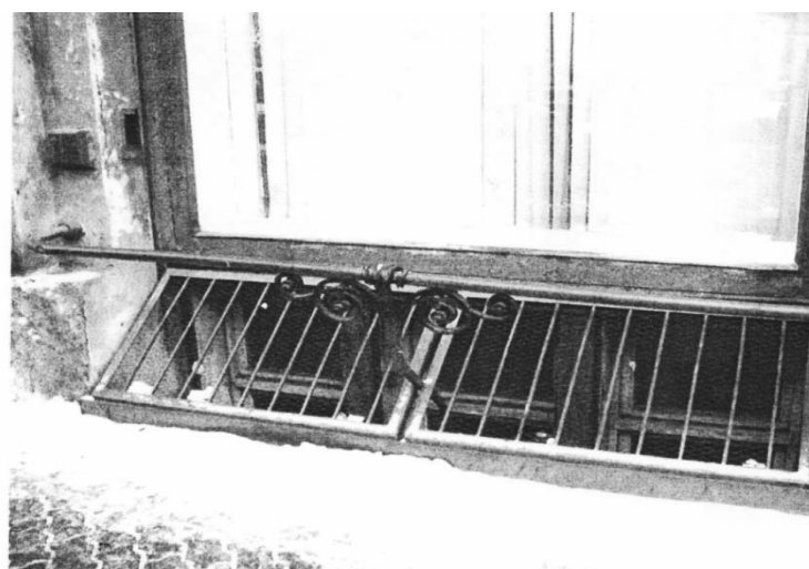
14. Ограждение приямка на фасаде по ул. Маркса.
