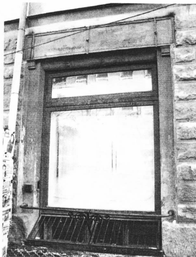
13. Окно первого этажа на фасаде по ул. Маркса
