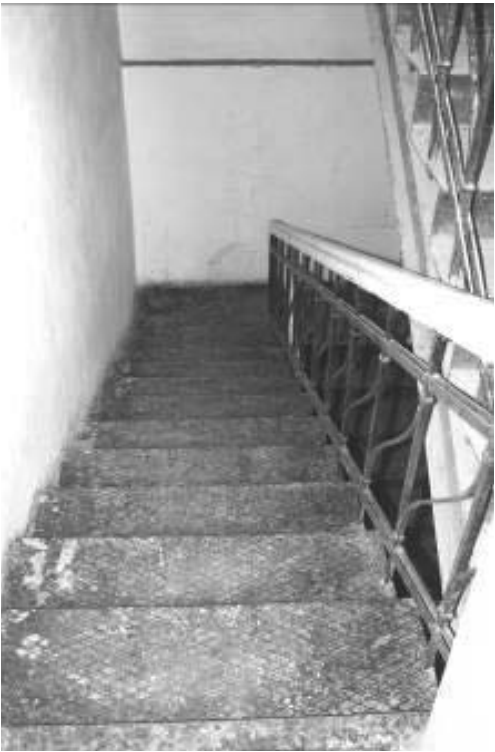
Лестница. Помещение № 14 (в соответствии с техническим паспортом ОГУП «ОЦТИ – Областное БТИ» г. Иркутск по состоянию на 20 декабря 2014 года)
