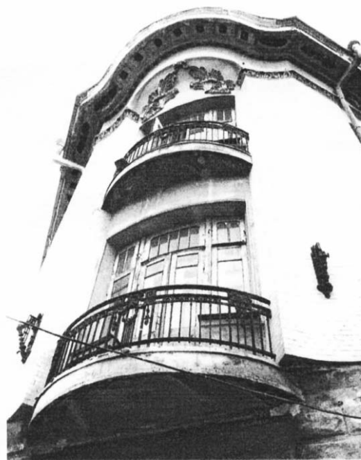
24. Срезанный угол, выходящий на пересечение улиц Маркса и Хмельницкого
