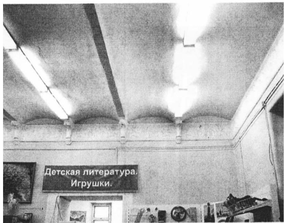
43. Лепной бордюр стен в торговом зале первого этажа
