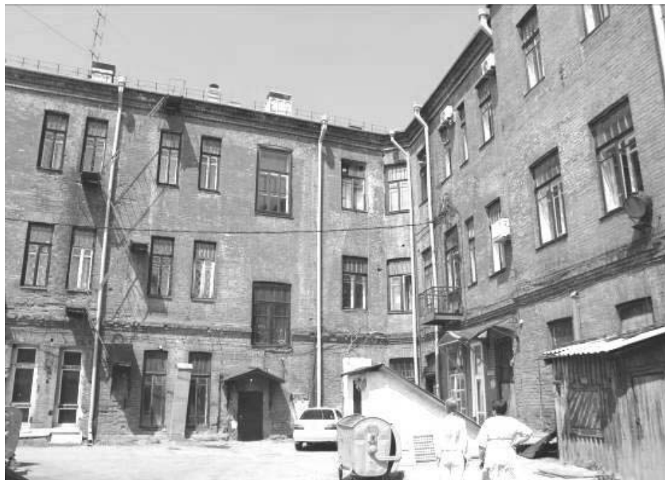
Фрагмент дворового фасада
