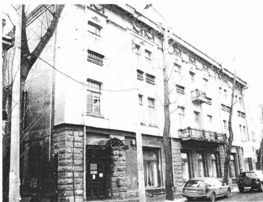
3. Фасад здания по ул. Хмельницкого
