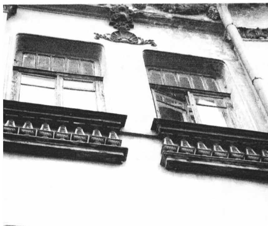
16. Окна третьего этажа на фасаде по ул. Маркса, декорированное подоконное поле окон
