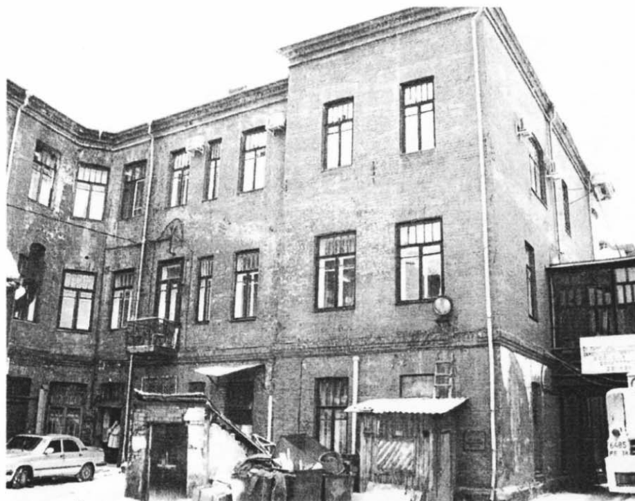
6. Дворовой фасад по ул. Хмельницкого
