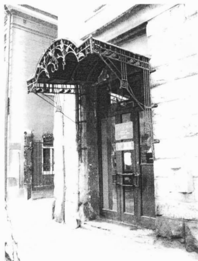
22. Козырёк над входом со стороны ул. Хмельницкого
