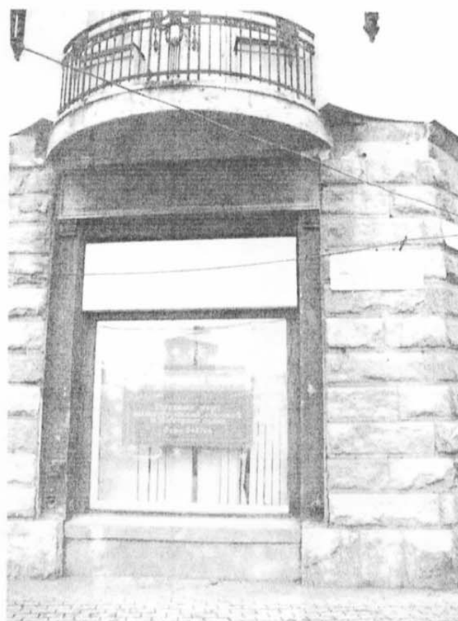
25. Окно первого этажа срезанного угла, выходящего на пересечение улиц Маркса и Хмельницкого
