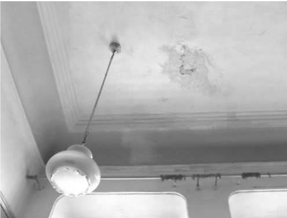
Потолок. Помещение № 35 (в соответствии с техническим паспортом ОГУП «ОЦТИ – Областное БТИ» г. Иркутск по состоянию на 20 декабря 2014 года)
