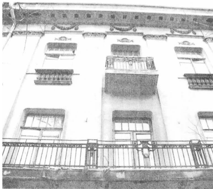
26. Окна, балконы второго и третьего этажей
