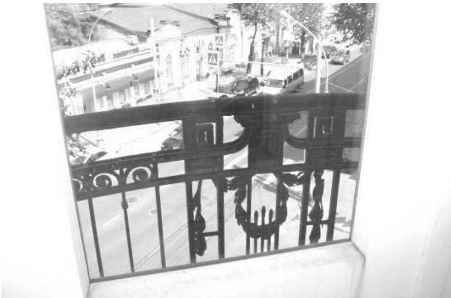
Фрагмент ограждения балкона. Помещение № 8 (в соответствии с техническим паспортом ОГУП «ОЦТИ – Областное БТИ» г. Иркутск по состоянию на 20 декабря 2014 года) Помещение № 8
