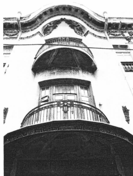
11. Центральная часть фасада по ул. Маркса, балконы второго и третьего
