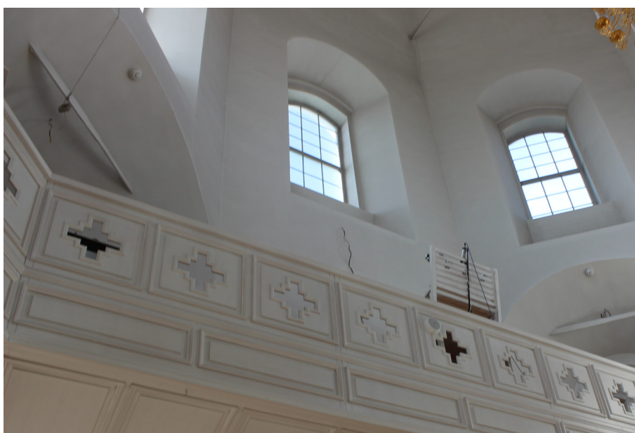
Фото Н.В. Шастун, октябрь 2018 г. Балкон хор.
