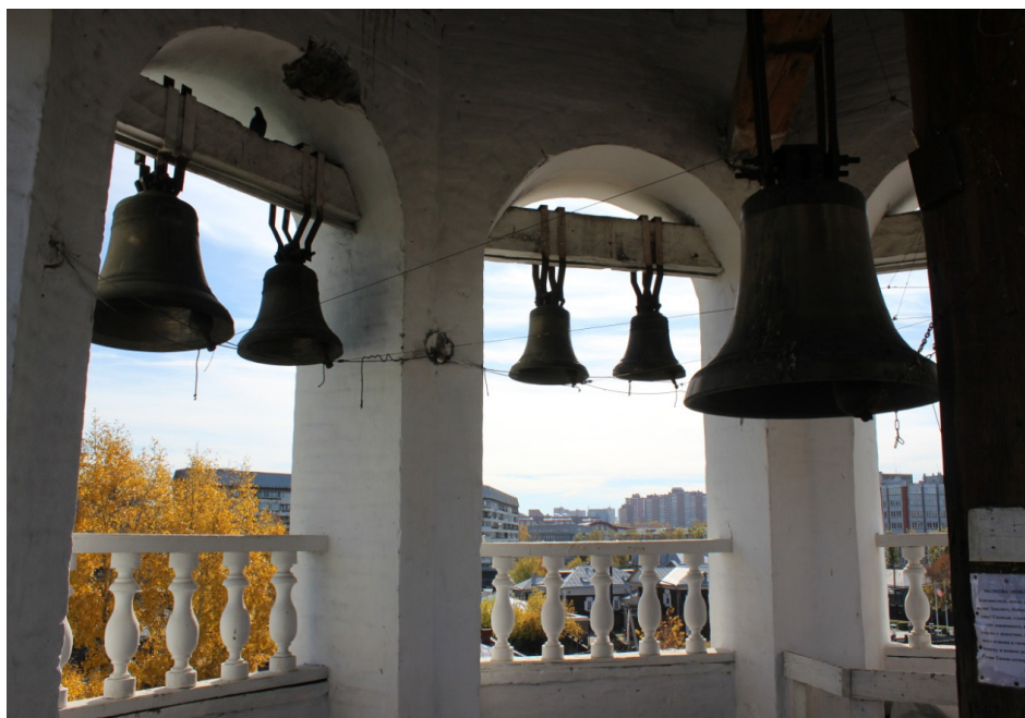
Фото Н.В. Шастун, октябрь 2018 г. Полуциркульные проемы колокольни с балюстрадой.
